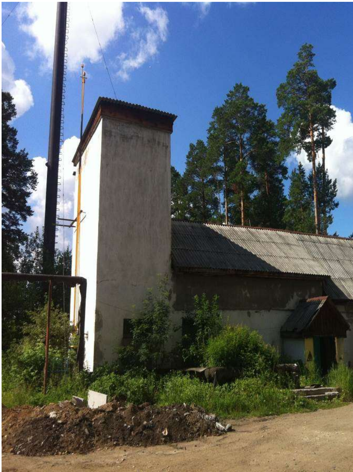
Рис.11. Котельная п. Верхняя Сысерть.
