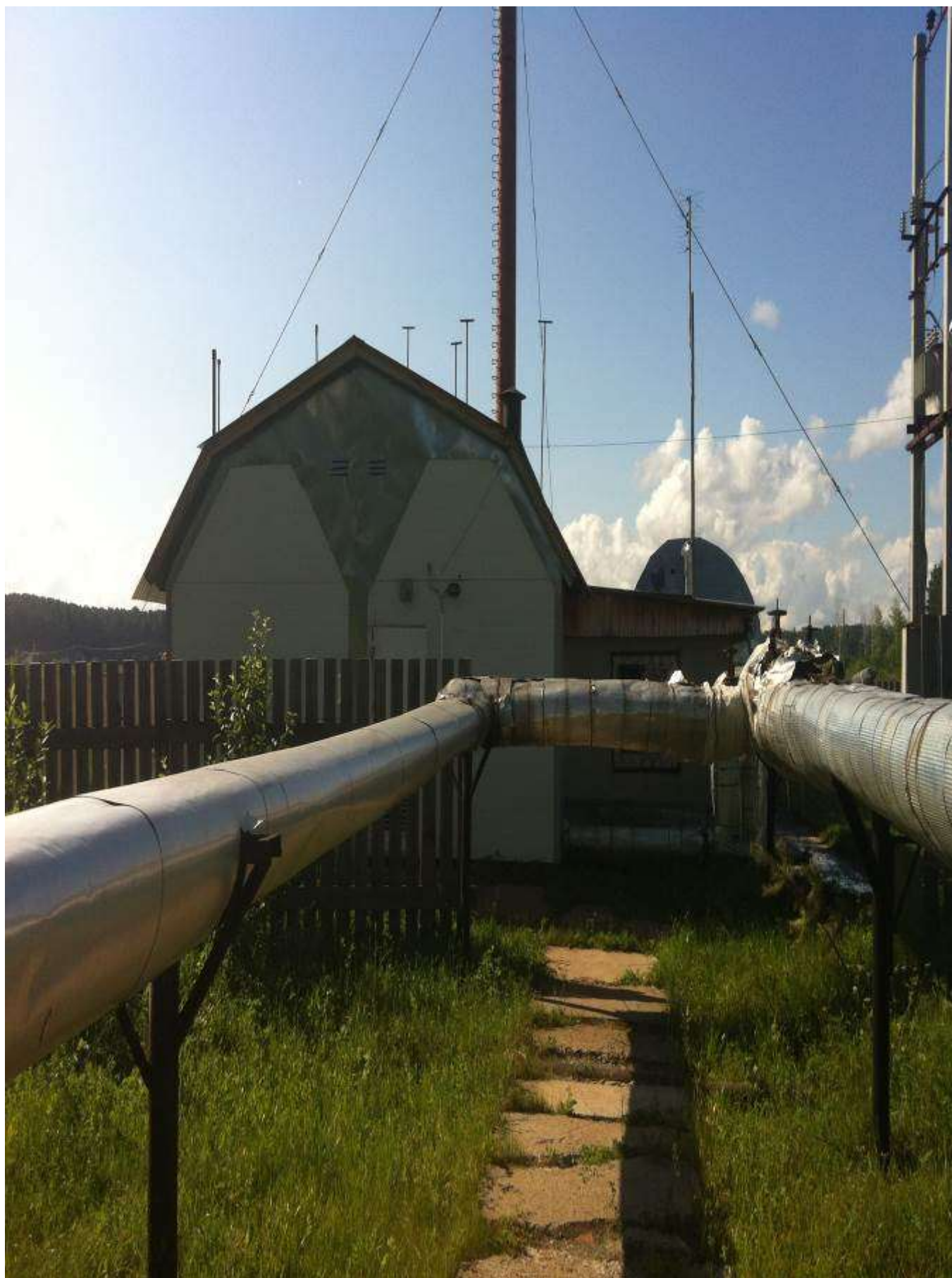
Рис. 8. Котельная с. Кашино.
