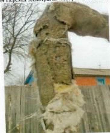
Рис. 4.136 Разрушение теплоизоляции
