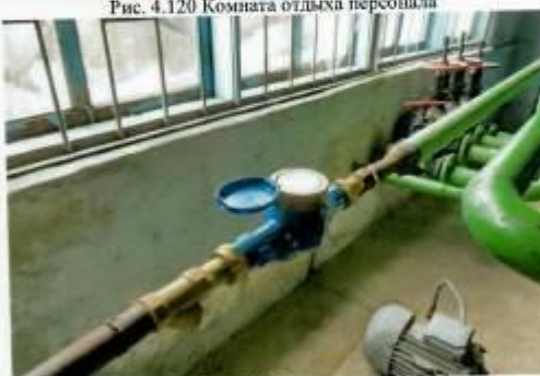
Рис. 4.122 Счетчик воды
