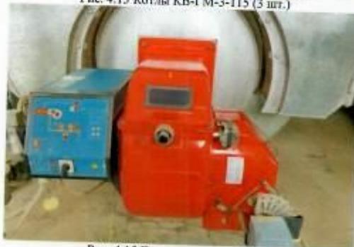
Рис. 4.15 Горелка газовая Unigas
