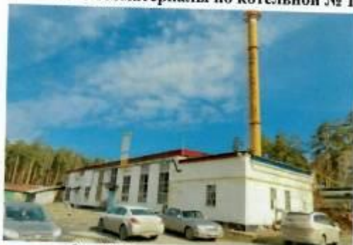
Рис. 4.1 Общий вид здания котельной
