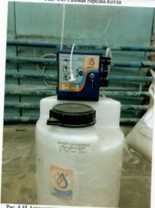
Рис. 4.45 Автоматическая система дозирования реагентов
