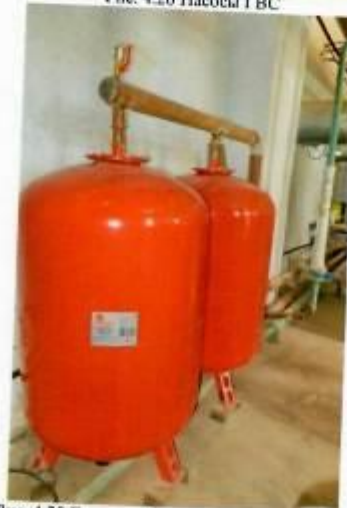
Рис. 4.28 Баки мембранные расширительные
