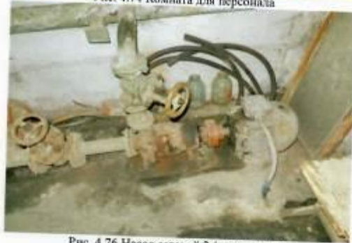
Рис. 4.76 Насос сетевой 2 (исправлен)
