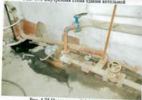
Рис. 4.75 Насос сетевой 1 (основной)
