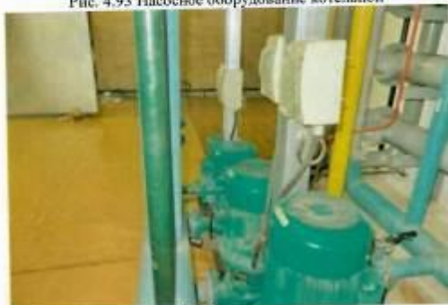
Рис. 4.95 Сетевые насосы
