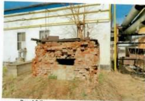
Рис. 4.2 Основание старой дымоходной трубы
