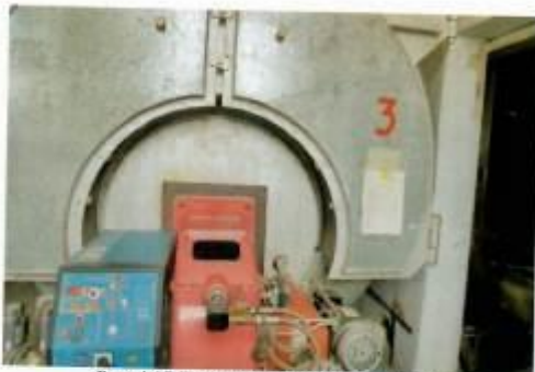
Рис. 4.17 Горелка газодизельная Uprgas
