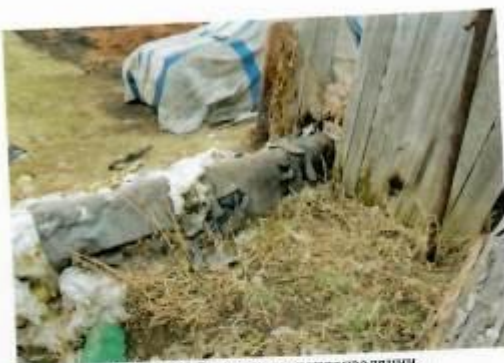
Рис. 4.140 Разрушение теплоизоляции
