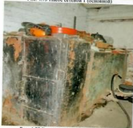
Рис. 4.77 Емкость стальная для подпитки
