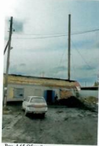
Рис. 4.65 Общий вид здания котельной
