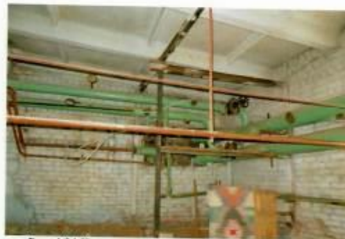
Рис. 4.24 Помещение под дизельную ёмкость (резерв)
