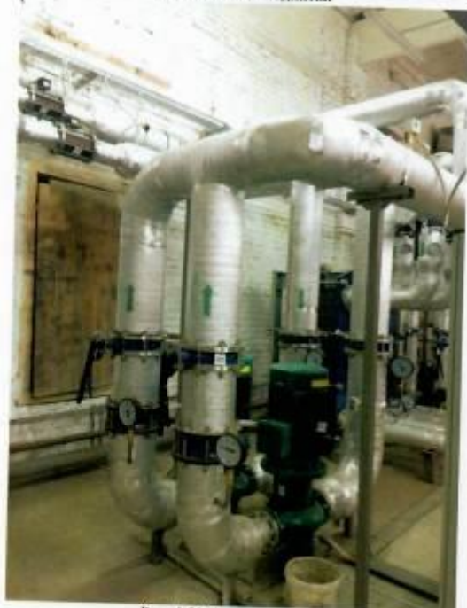
Рис. 4.51 Сетевые насосы
