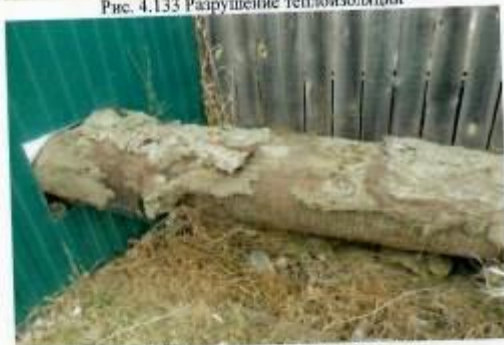
Рис. 4.135 Разрушение теплоизоляции
