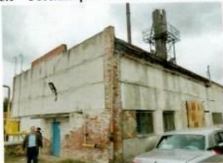
Рис. 4.107 Общий вид здания котельной
