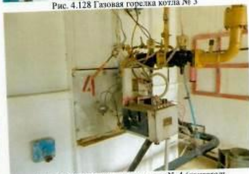
Рис. 4.130 Газовая горелка котла № 4 (двигатель демонтирован)
