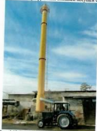
Рис. 4.12 Дымовая труба (установлена в 2006г.)
