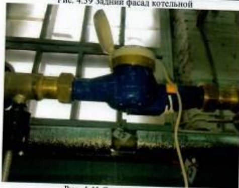
Рис. 4.41 Счетчик подпитки
