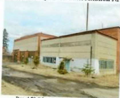
Рис. 4.79 Общий вид здания котельной
