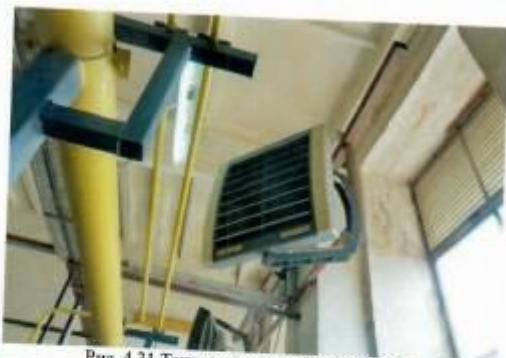
Рис. 4.31 Теплоventилиатор Voolcano VR1
