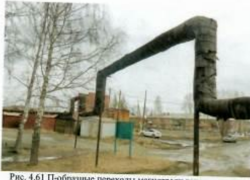
Рис. 4.61 П-образные переходы магистрали теплосети над проезжей частью
