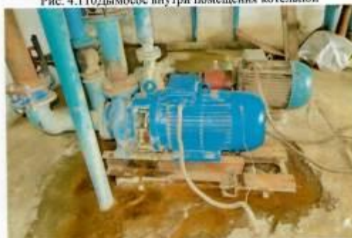
Рис. 4.112 Насосы сетевые
