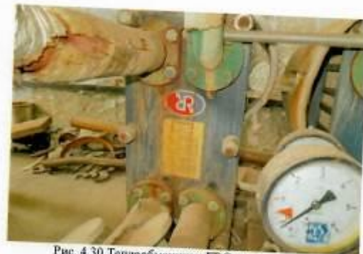
Рис. 4.30 Теплообменники ГВС пластинчатые
