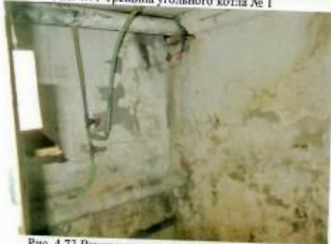
Рис. 4.73 Внутренняя стена здания котельной
