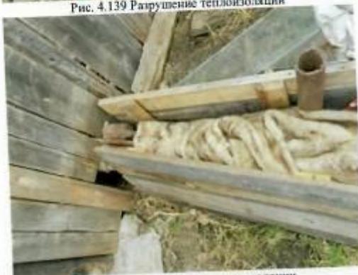
Рис. 4.141 Разрушение теплоизоляции
