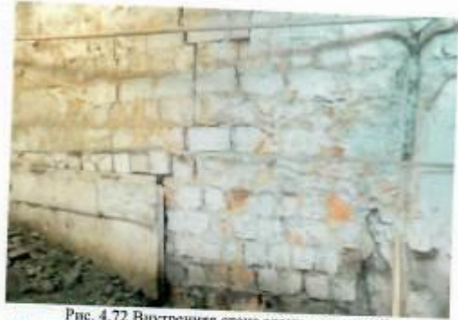
Рис. 4.72 Внутренняя стена здания котельной
