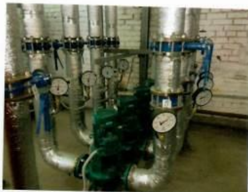
Рис. 4.54 Насосы рециркуляции
