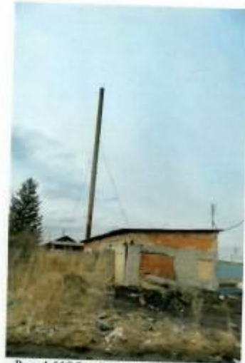
Рис. 4.66 Общий вид здания котельной
