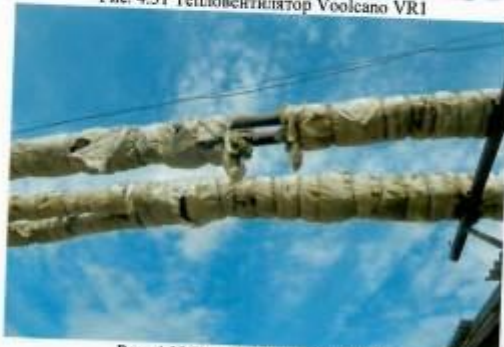
Рис. 4.33 Теплотрасса "воздушка"
