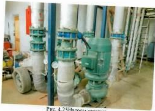
Рис. 4.25 Насосы сетевые
