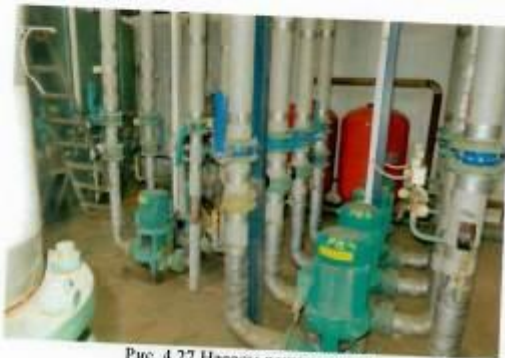
Рис. 4.27 Насосы рециркуляции
