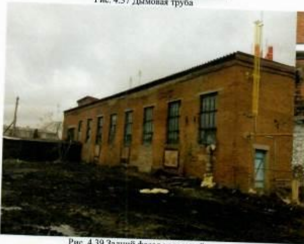
Рис. 4.39 Задний фасад котельной
