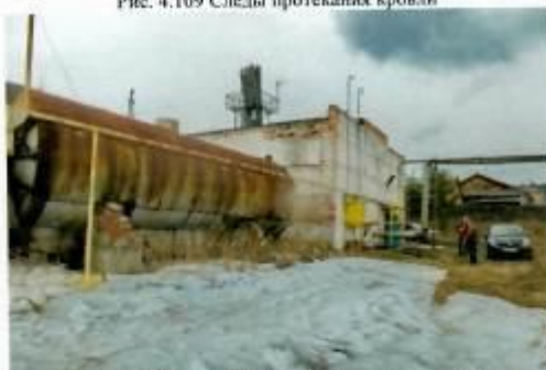
Рис. 4.111 Общий вид здания котельной
