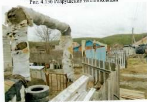
Рис. 4.138 Разрушение теплоизоляции
