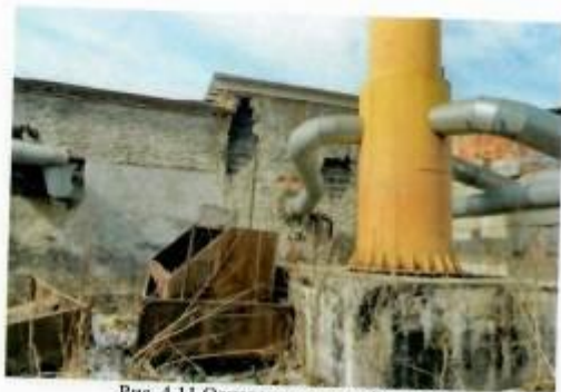
Рис. 4.11 Основание дымовой трубы
