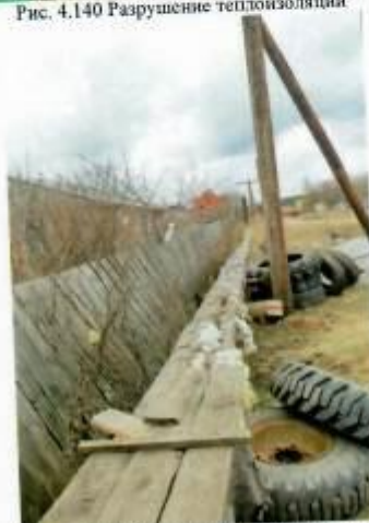
Рис. 4.142 Разрушение теплоизоляции
