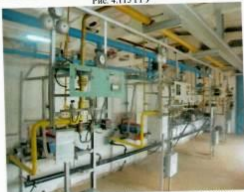
Рис. 4.117 Котлы водогрейные с газовыми горелками
