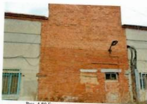
Рис. 4.80 Боковая стена здания котельной
