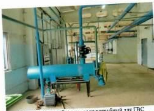
Рис. 4.123 Теплообменник кожухотрубный для ГВС
