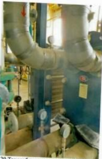
Рис. 4.29 Теплообменники отопления пластинчатые
