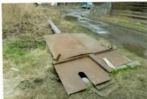
Рис. 4.99 Колодезь магистральный тепловой сети
