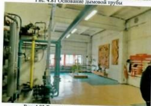
Рис. 4.83 Внутреннее помещение котельной
