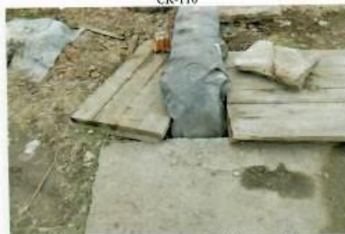
Рис. 4.100 Колодезь магистральный тепловой сети
