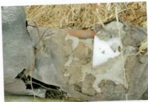
Рис. 4.133 Разрушение теплоизоляции
