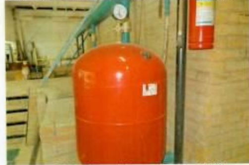
Рис. 4.90 Мембранный бак расширительный 200л
