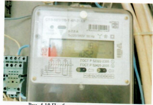
Рис. 4.18 Прибор учета электроэнергии
