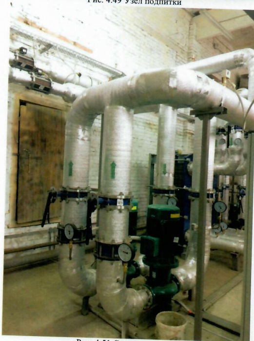
Рис. 4.51 Сетевые насосы
