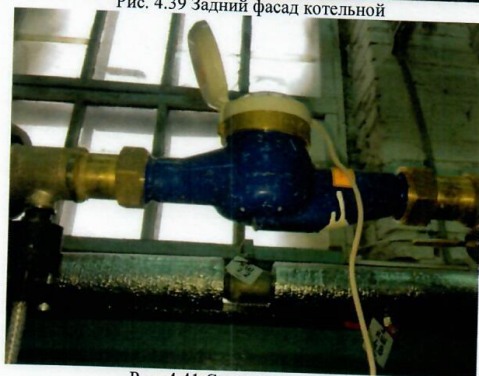
Рис. 4.41 Счетчик подпитки
