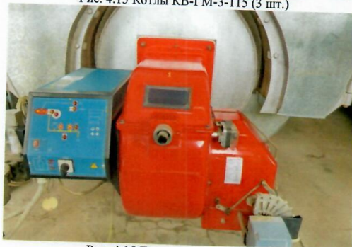
Рис. 4.15 Горелка газовая Unigas
