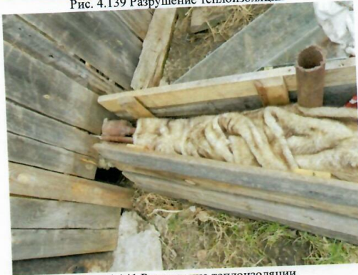
Рис. 4.141 Разрушение теплоизоляции
