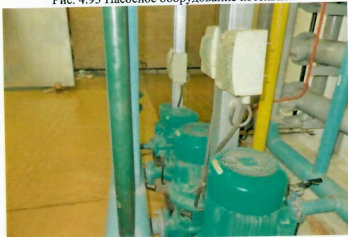
Рис. 4.95 Сетевые насосы
