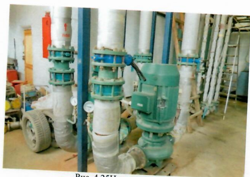
Рис. 4.25 Насосы сетевые
