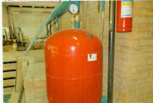
Рис. 4.90 Мембранный бак расширительный 200л
