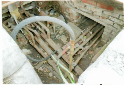
Рис. 4.102 Колодец магистральный тепловой сети
