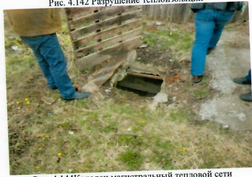
Рис. 4.144 Колодец магистральный тепловой сети
