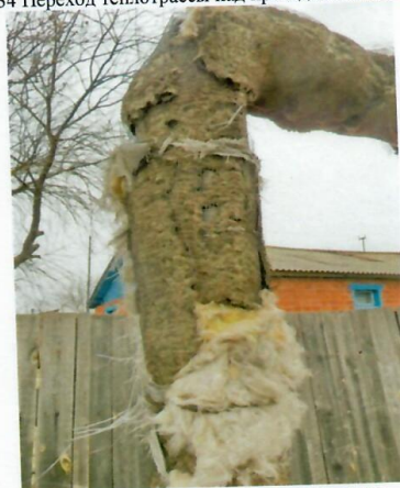
Рис. 4.136 Разрушение теплоизоляции
