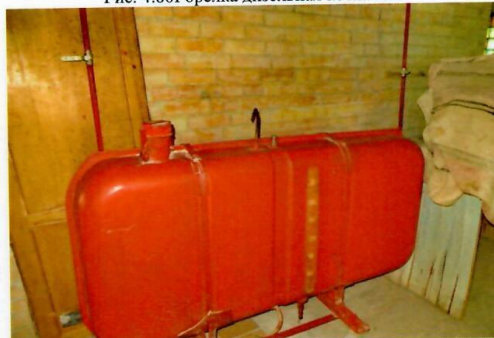
Рис. 4.88 Емкость для резервного топлива (не используется)
