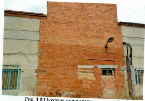
Рис. 4.80 Боковая стена здания котельной
