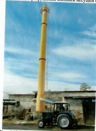
Рис. 4.12 Дымовая труба (установлена в 2006г.)
