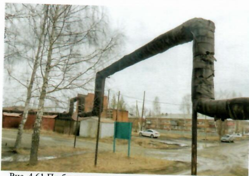
Рис. 4.61 П-образные переходы магистрали теплосети над проезжей частью
