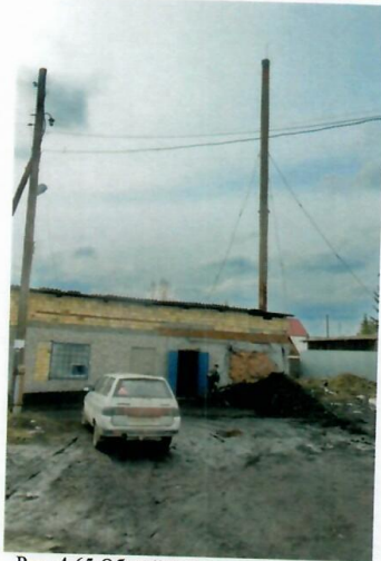
Рис. 4.65 Общий вид здания котельной
