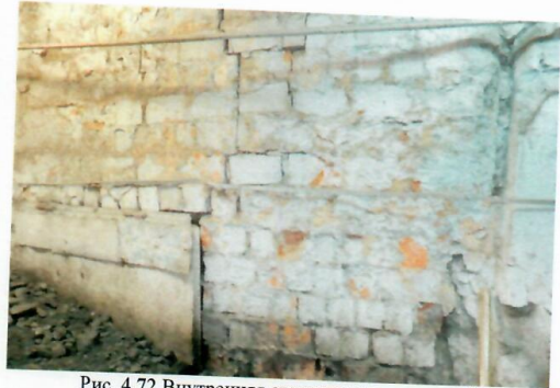
Рис. 4.72 Внутренняя стена здания котельной
