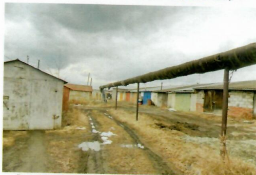
Рис. 4.59 Надземный участок магистральной теплосети
