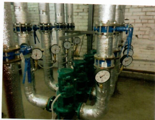
Рис. 4.54 Насосы рециркуляции
