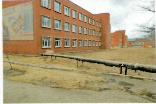
Рис. 4.106 Надземная теплотрасса. Ввод в здание училища
