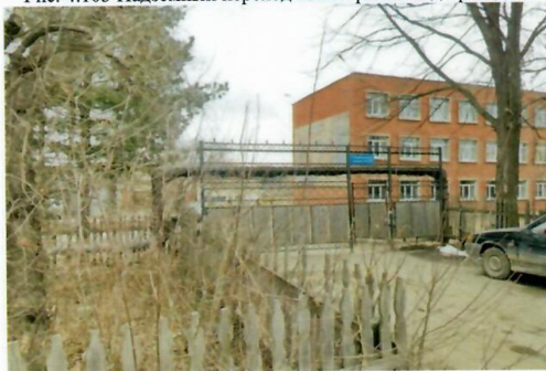
Рис. 4.105 Въезд на территорию училища к котельной
