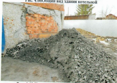
Рис. 4.68 Площадка хранения каменного угля
