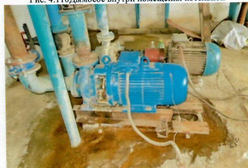
Рис. 4.112 Насосы сетевые
