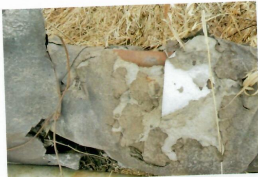
Рис. 4.133 Разрушение теплоизоляции
