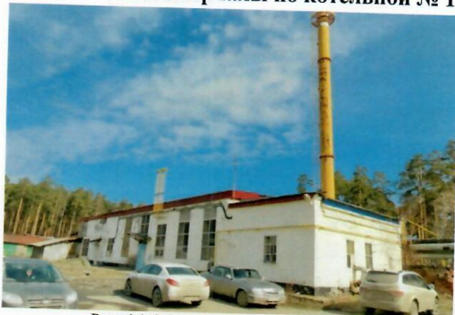
Рис. 4.1 Общий вид здания котельной
