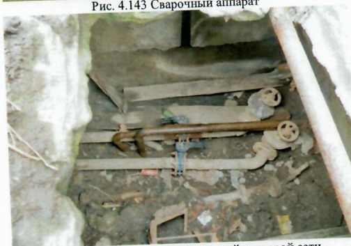
Рис. 4.145 Колодец магистральный тепловой сети
