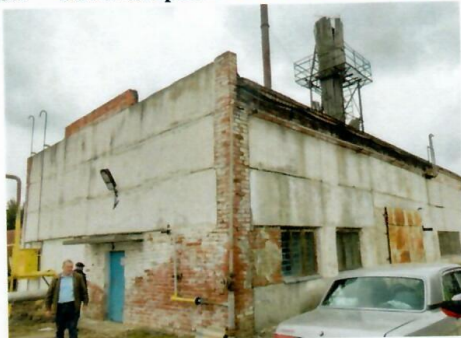
Рис. 4.107 Общий вид здания котельной
