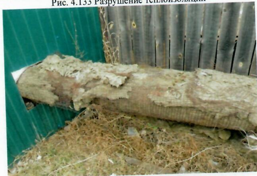
Рис. 4.135 Разрушение теплоизоляции
