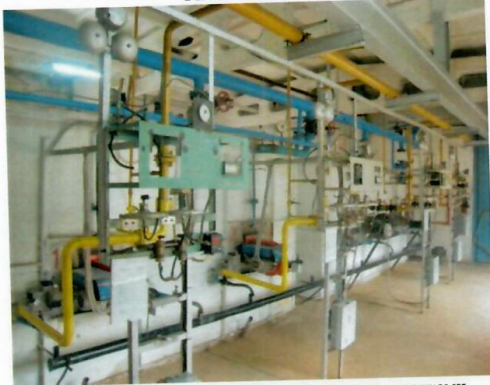
Рис. 4.117 Котлы водогрейные с газовыми горелками
