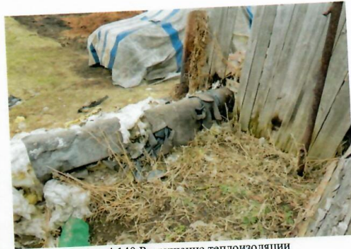
Рис. 4.140 Разрушение теплоизоляции
