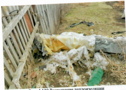
Рис. 4.139 Разрушение теплоизоляции
