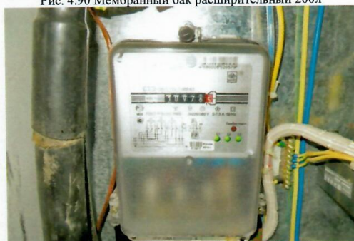
Рис. 4.92 Прибор учета электроэнергии
