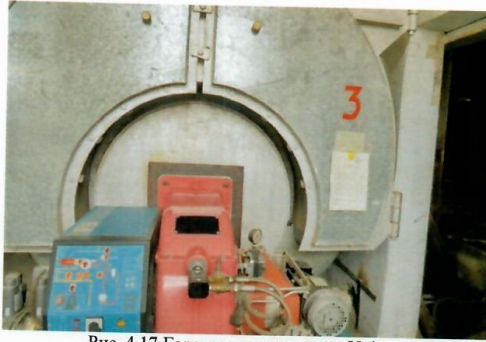
Рис. 4.17 Горелка газодизельная Unigas
