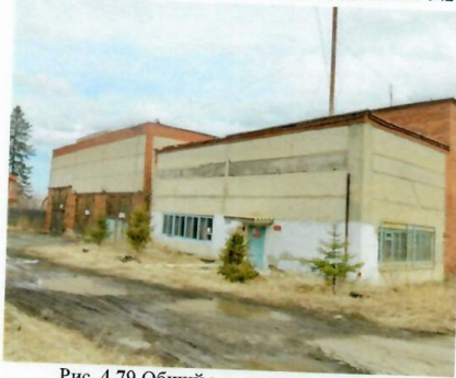
Рис. 4.79 Общий вид здания котельной
