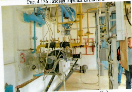
Рис. 4.128 Газовая горелка котла № 3
