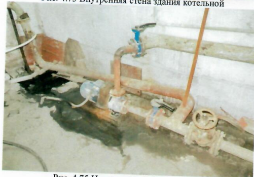
Рис. 4.75 Насос сетевой 1 (основной)
