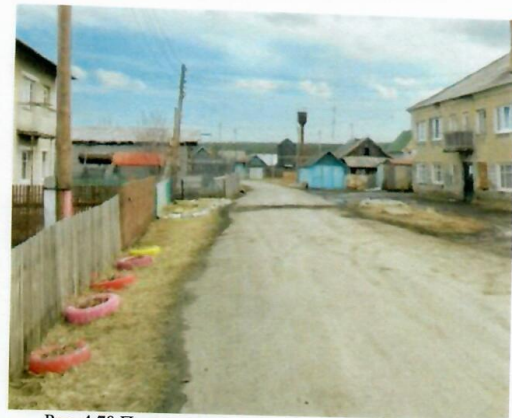
Рис. 4.78 Подземная теплотрасса, проход под дорогой
