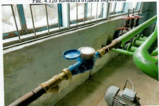
Рис. 4.122 Счетчик воды
