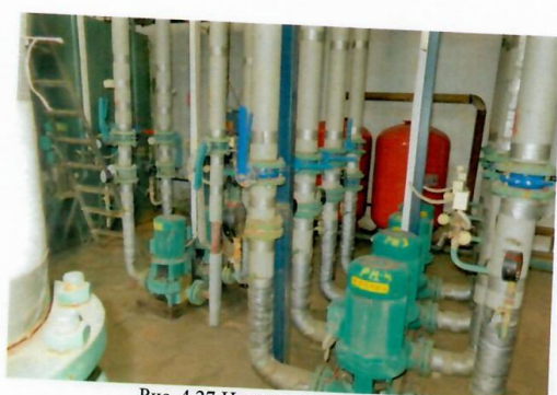
Рис. 4.27 Насосы рециркуляции
