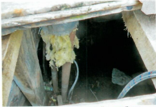
Рис. 4.101 Колодец магистральный тепловой сети
