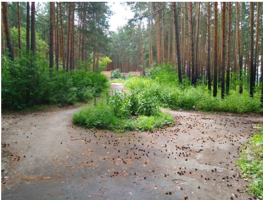
Рис.3. Существующая асфальтированная пешеходная дорожка
